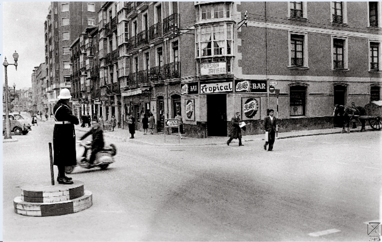
Fig. 4. Bar Tropical, 1960. © ARQUÉ. (ARQ-1294_12(2)) Archivo Municipal de Vitoria-Gasteiz.
